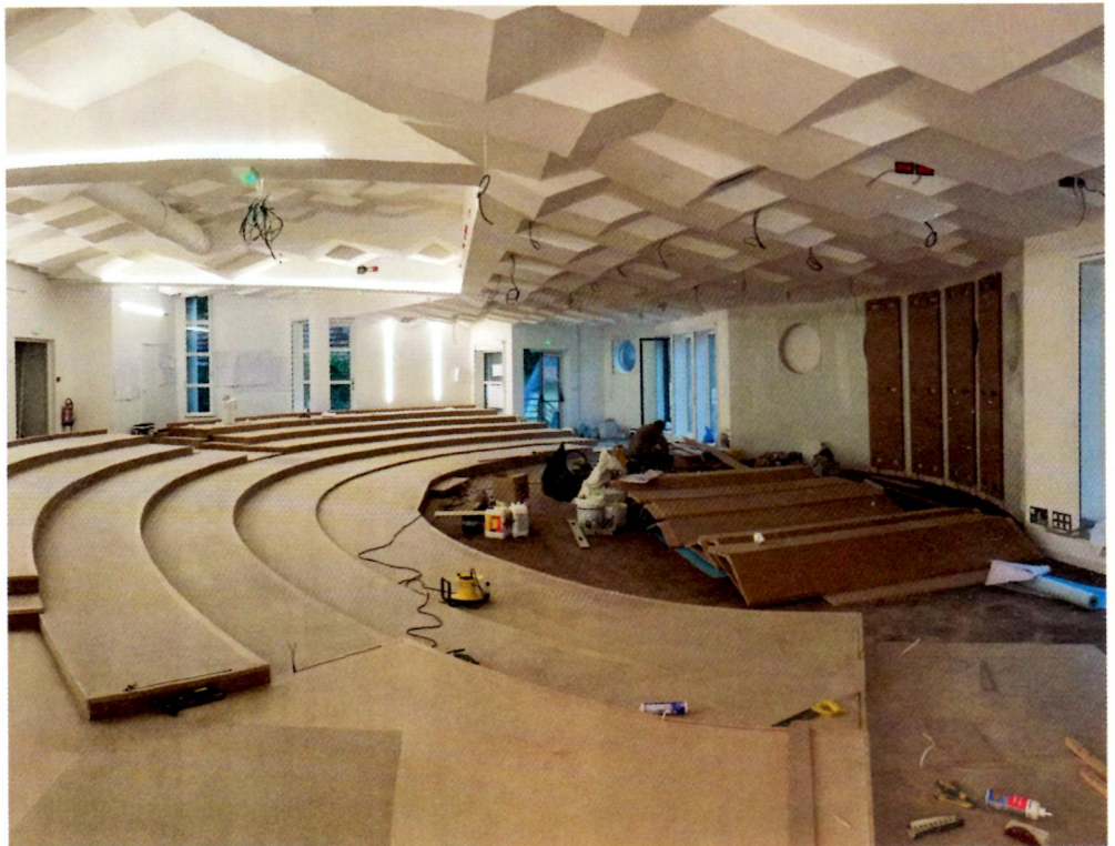
Les travaux de l'auditorium touchent à leur fin.
